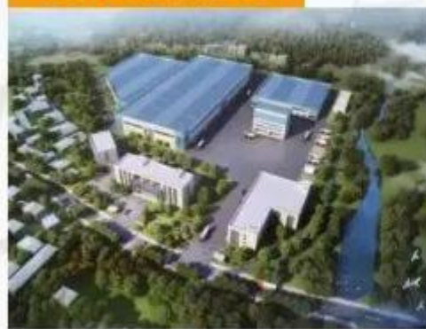
建筑垃圾消纳监测
